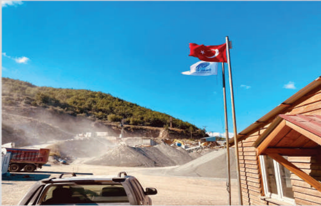
Önal Bazalt Üretim Tesisi
